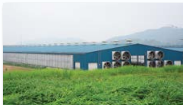
Chuồng trại với hệ thống làm mát hiện đại tại trang trại Hà Tĩnh
